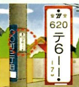
電柱の管理番号
