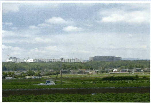
東京ドーム4.5個分の広大な敷地に建設中のTSMCの工場
