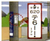
電柱の管理番号
